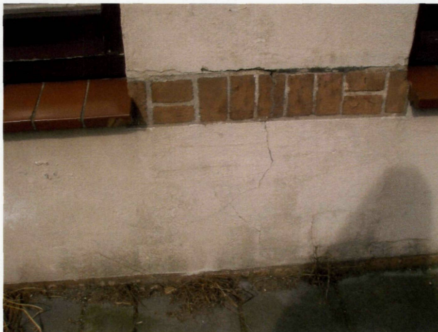
Foto 2: Scheur in de voorgevel bij nr. 40 in de borstwering
