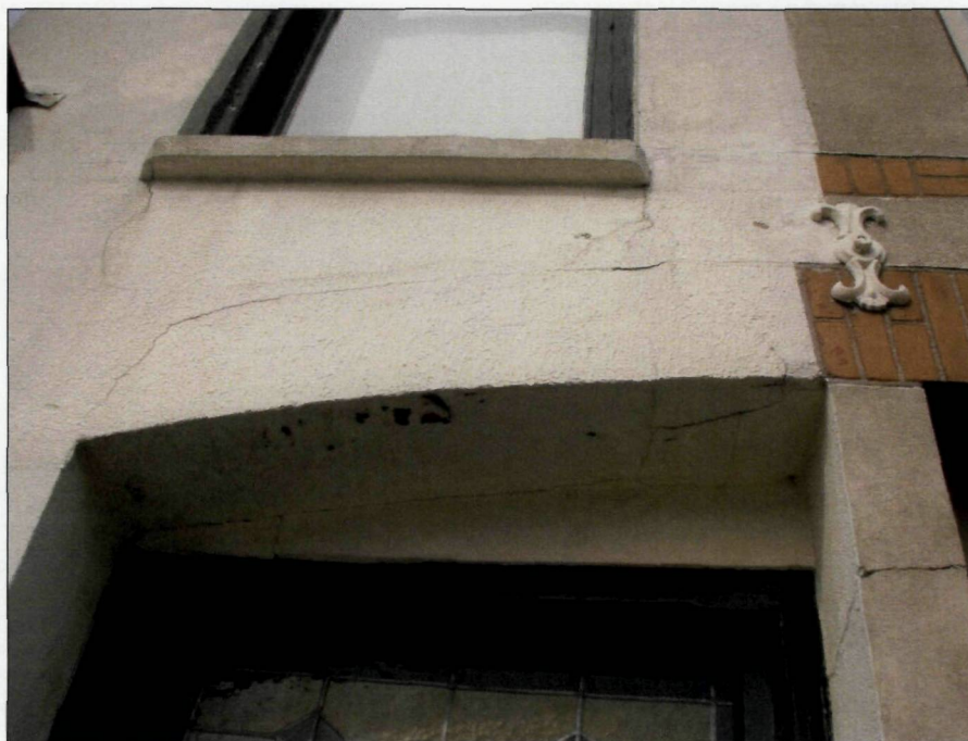
Foto 5: Diverse scheuren met name in de toog en de penant bij voorgevel nr. 42.
