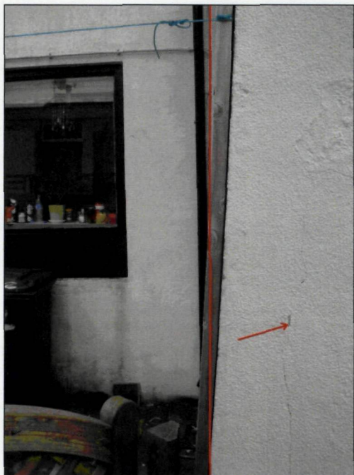
Foto 7: Duidelijke indicatie van de scheefstand van de achtergevel van nr. 42, genomen aan het eind van de steeg nabij de poort. De houten balk, waar de waslijn aan bevestigd is, is door de bewoner aangepast aan de scheefstand. Zie ook de scheurvorming in de linkerzijgevel (gele pijl).
