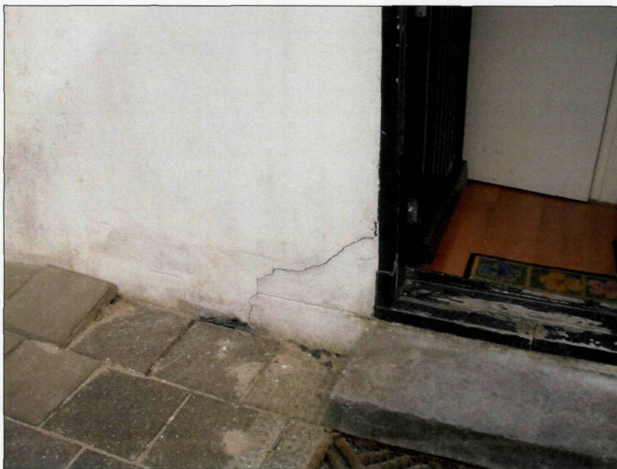
Foto 12: Scheurvorming (alleen in het stucwerk?) nabij voordeur nr. 42 en omhooggedrukte straattegel.
