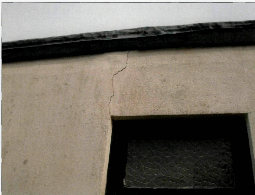
Foto 11: Doorgaande scheur vanaf de dakrand tot raamkozijn in de uitbouw van nr. 42.
