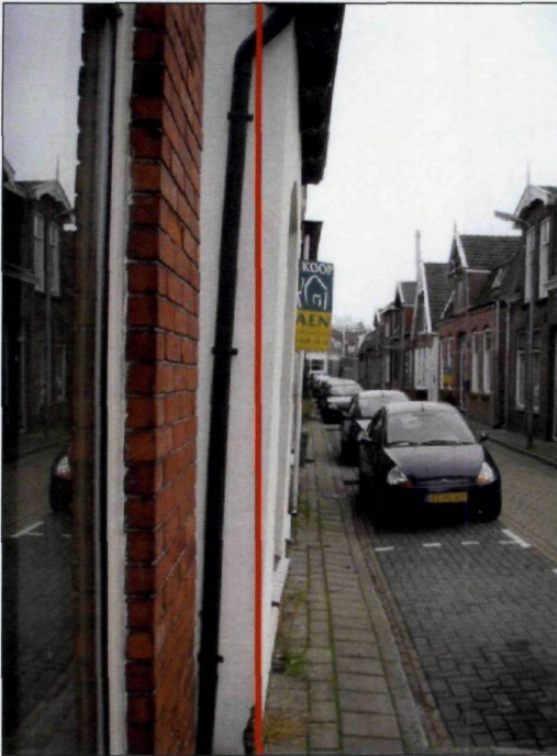
Foto 13: Duidelijk de scheefstand in beeld bij de voorgevel van nr. 42.
