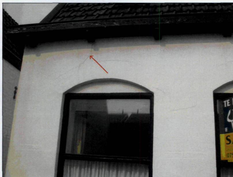
Foto 8: Doorgaande scheur vanaf de dakrand tot in de toog van de voorgevel van nr. 42.
