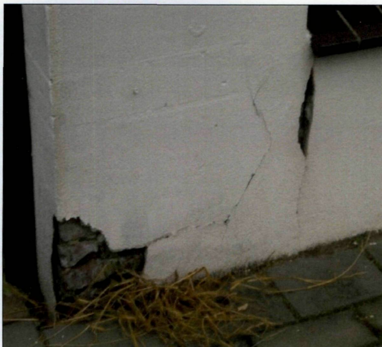
Foto 14: Scheurvorming in de rechterhoek van de straatgevel van nr. 42.
