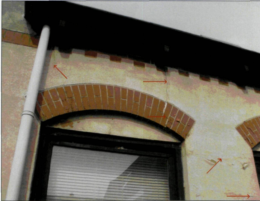
Foto 3: Doorgaande Scheur vanaf de dakrand tot in de toog bij nr. 40 in de voorgevel. Ook scheur rechts van hemelwaterafvoer. Ook horizontale scheurvorming in het stucwerk ter plaatse van de muurdam rechts van het raam.
