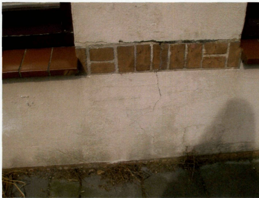
Foto 2: Scheur in de voorgevel bij nr. 40 in de borstwering
