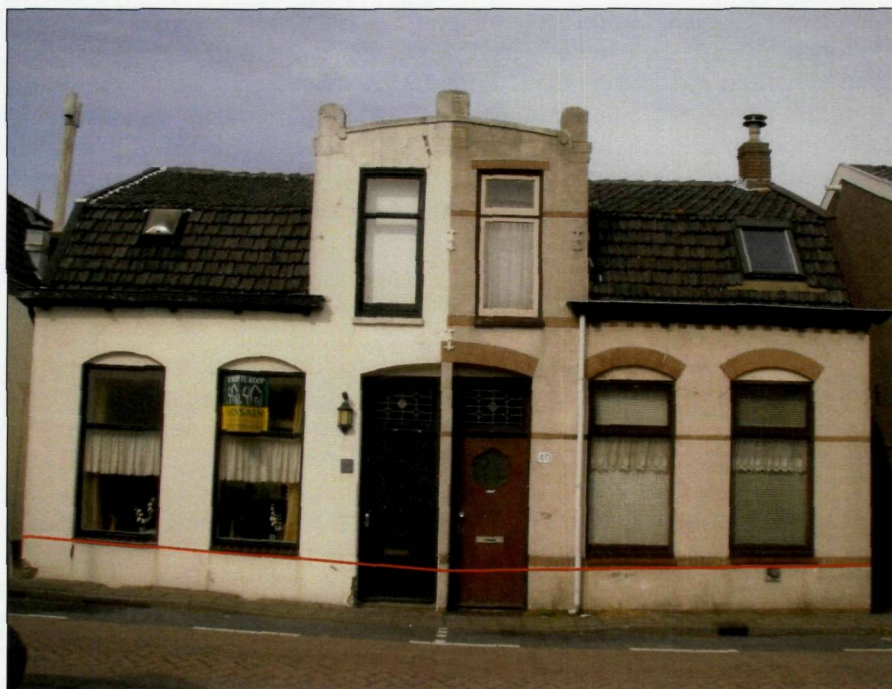
Foto 1: Voorgevels nummer 40 en 42. Duidelijk is de scheefstand c.q. verzakking te zien bij nummer 42 (links op de foto). Oorspronkelijk lagen de onderkanten van de raamkozijnen op 1 lijn.
