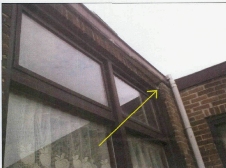
Foto 16: Kiervorming nabij aansluiting aanbouw nr. 40, mogelijk door uitgevallen lintvoeg.
