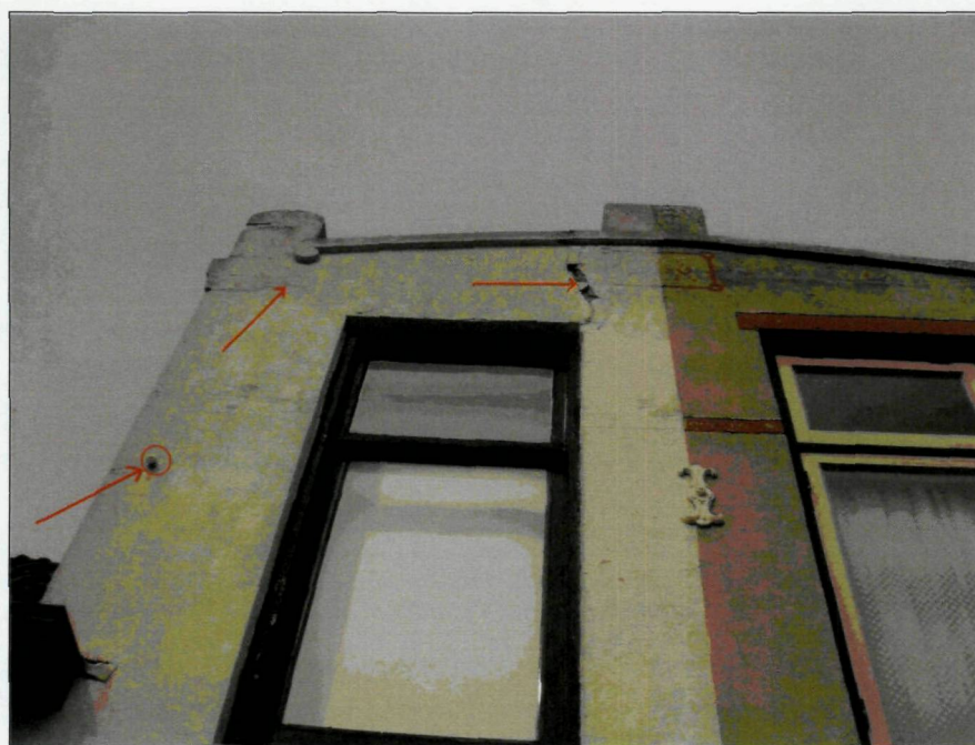
Foto 6: Scheuren en loszittend stucwerk vanaf de dakrand tot bovenkant raamkozijn in de voorgevel van nr. 42. Links op de foto op ongeveer de halve hoogte van de opbouw is te zien dat het muuranker niet meer volledig aanwezig is.
