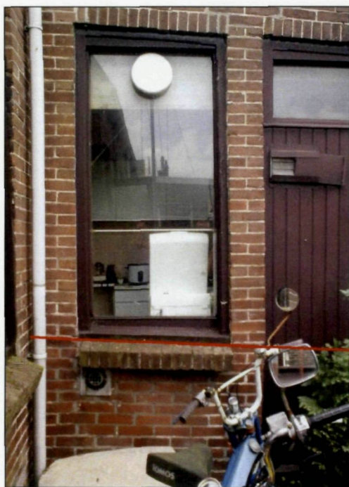
Foto 17: Zichtbare scheefstand in de aanbouw van nr. 40 onderkant raamkozijn.
