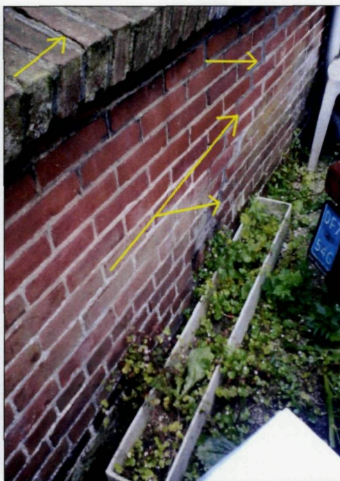
Foto 18: Aangeheelde scheuren in borstwering en scheur in voeg raamdorpelsteen.
