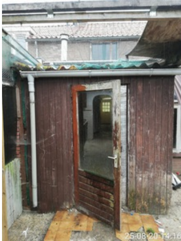
foto 23 deel van het portaal achtergevel.
