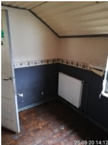
foto 9 deel vloer, wand en plafond kamer van de eerste verdieping.
