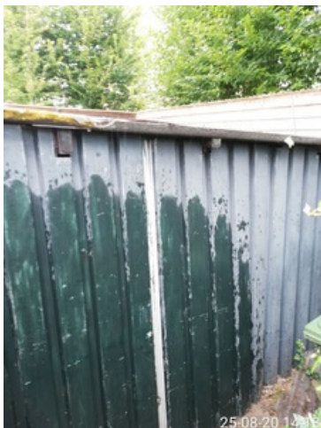
foto 34 buitenzijde aangebouwde berging.
