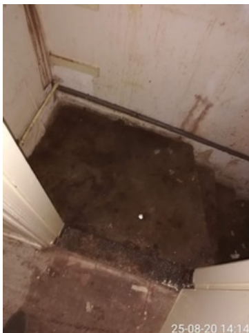
foto 13 deel van trap naar de kelder.
