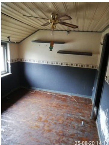
foto 7 deel vloer, wand en plafond kamer van de eerste verdieping.
