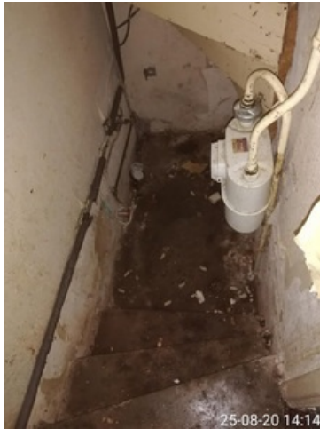
foto 14 deel van trap naar de kelder met nutsmeter.
