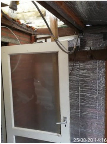
foto 21 deel van de tussenruimte, wanden en dak.
