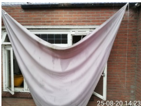
foto 42 deel achtergevel van de woning.
