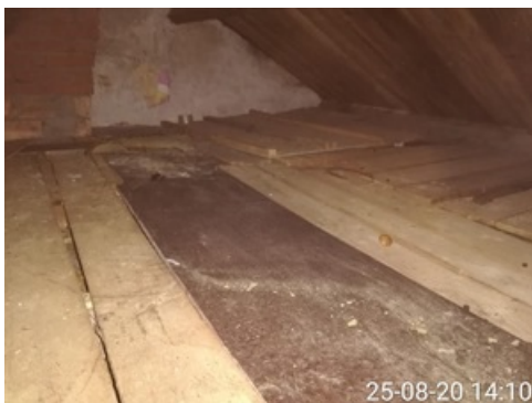
foto 3 deel vloer vliering en woningscheidende wand vliering.jpg
