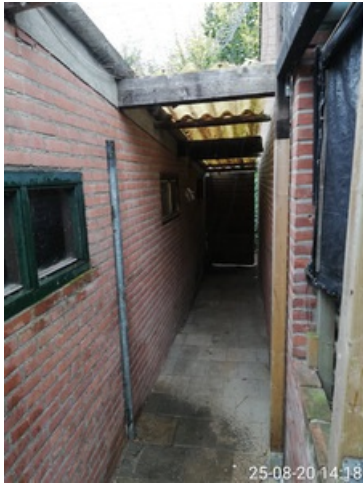
foto 33 in de gang naast de berging.
