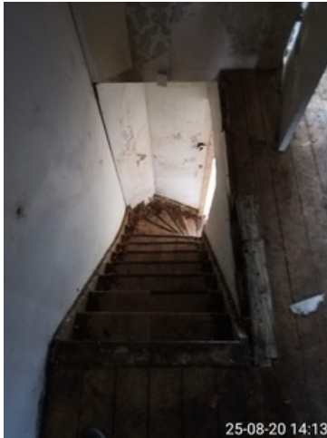
foto 8 deel vloer en trap van de eerste verdieping naar begane grond.
