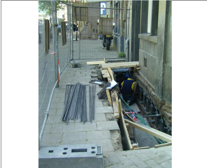
Nieuwezijds Voorburgwal 23 1012 RC Amsterdam Werkzaamheden plaatsing verstevigingsbalk fundering voorgevel augustus 2005
