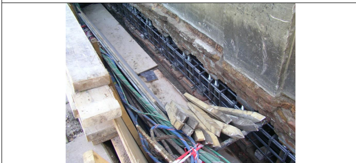
Nieuwezijds Voorburgwal 23 1012 RC Amsterdam Werkzaamheden plaatsing verstevigingsbalk fundering voorgevel augustus 2005
